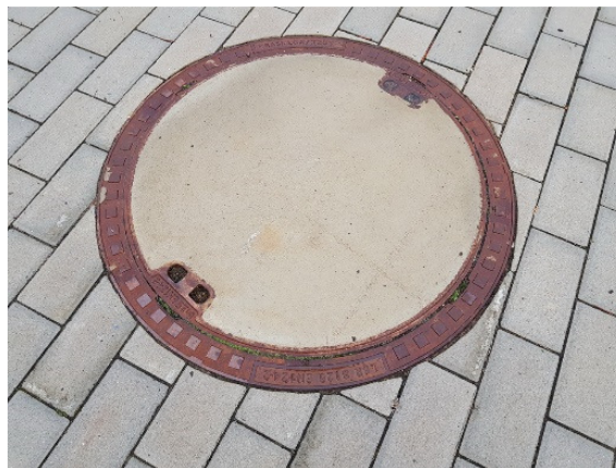
Vzor nově osazeného poklopu v chodníku
